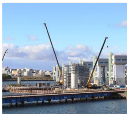
▲ 淀川大堰閘門
