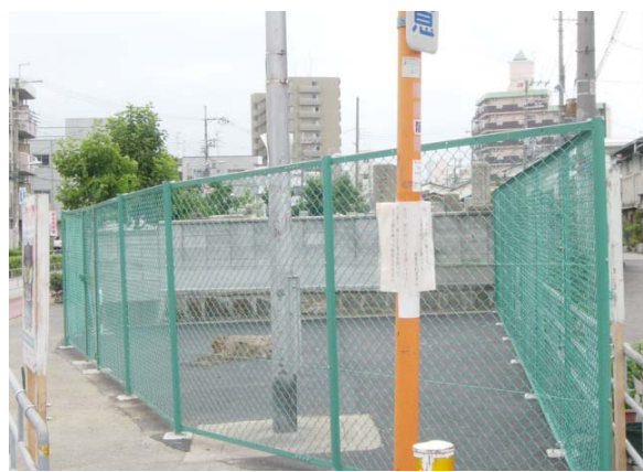
H20.7 フェンスが完成
